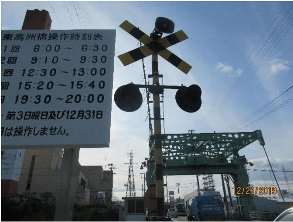
「尼崎の可動橋」
