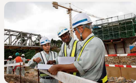
ガーナにおける国道八号線の改修工事 写真提供: 飯塚明夫/JICA
