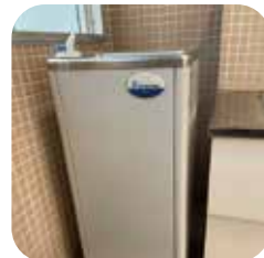
冷水器の設置
